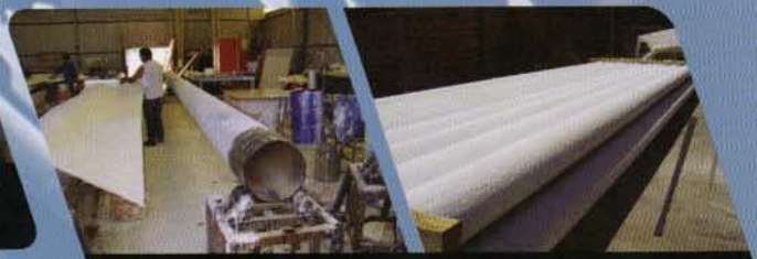
Revestimiento FRP con Carga de Cuarzo de Cañerías de Acero al Carbono para Trasvasije de Hidrocarburos (COPEC)
