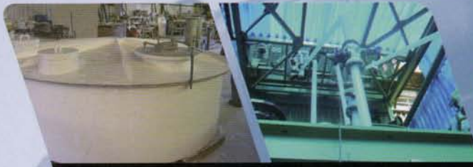
Ampliación planta metales nobles 5º horno de selenio (CODELCO - Ventanas)
