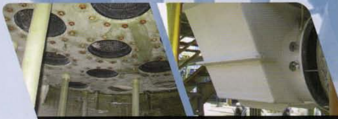
Fabricación e Instalación de Componentes FRP para Filtro MINS Gases Sulfúricos Planta de Acido (Molymet)
